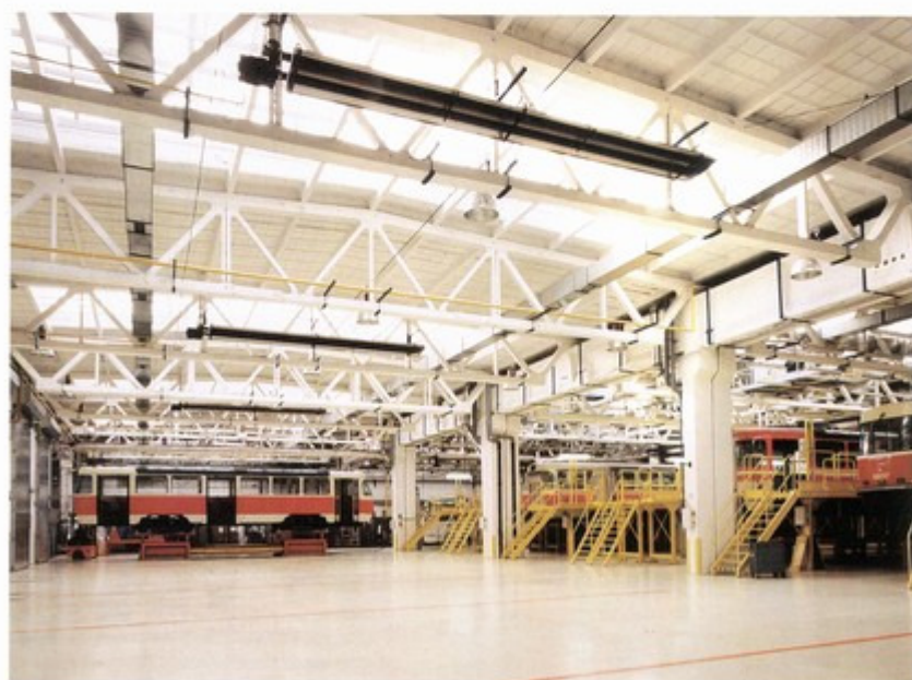
Tramvajové depo v Praze
